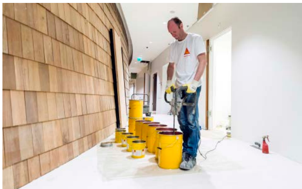
KORAK 1. Nakon pregleda i pripreme podloge čišćenjem (i po potrebi brušenja, pjeskarenja ili izravnavanja), počeli smo miješati tekuće materijale
