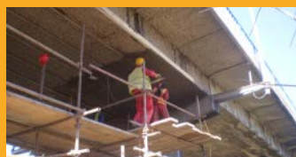
SANACIJA I ZAŠTITA
