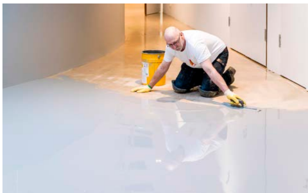
KORAK 3. Samonivelirajući materijali primjenjuju se u jednom ili više slojeva kako bi se stvorila ravna monolitna podloga. Stručnjaci će razliti i distribuirati tekući materijal pomoću posebnih gladilica, ručnih gletera, stajaćih gletera i ježastih valjaka, kako bi se osigurala savršeno ravna i glatka površina.
