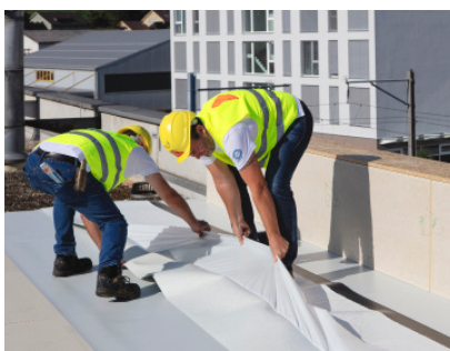
1. Uklonite Sarnafil® AT FSA P zaštitu
