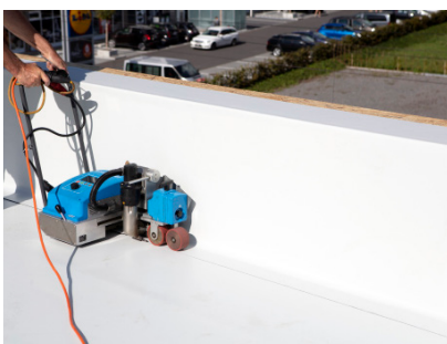
5. Završno zavarivanje vrućim zrakom
