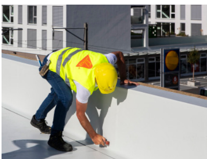
4. Pritisnite membranu pomoću odgovarajućeg valjka
